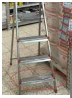
Gradini danneggiati/rotti sulla scala che causano un utilizzo non sicuro
