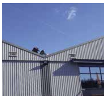
Dachinspektion arbeitet ohne Sicherheitsgurt oder Dachkantenschutz.
