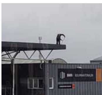
Der Auftragnehmer reinigt das Dach ohne Sicherheitsgeschirr oder Absturzsicherung.
