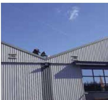
Trabajos de inspección de tejados sin arnés de seguridad ni protección de los bordes del tejado.
