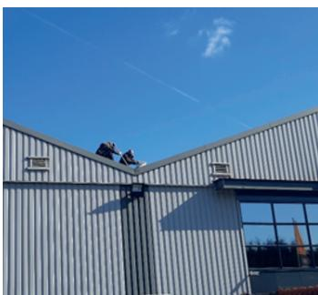
L'inspection des toits s'effectue sans harnais de sécurité ni protection des bords de toit.
