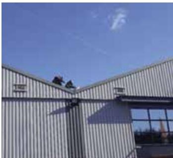
L'ispezione del tetto funziona senza imbracatura di sicurezza o protezione del bordo del tetto.
