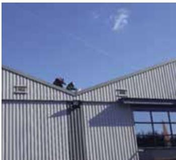
A inspecção do telhado funciona sem arnês de segurança ou protecção da borda do telhado.
