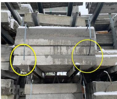
Betonbalken könnten nach dem Durchtrennen der Metallbänder in der Höhe leicht herunterfallen.
