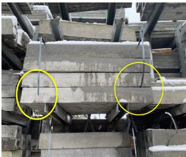
As vigas de betão podem cair facilmente após o corte das cintas metálicas em altura.
