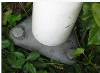
een kantelbare vlaggenmast is verankerd met 3 punten. (op een betonblok)
